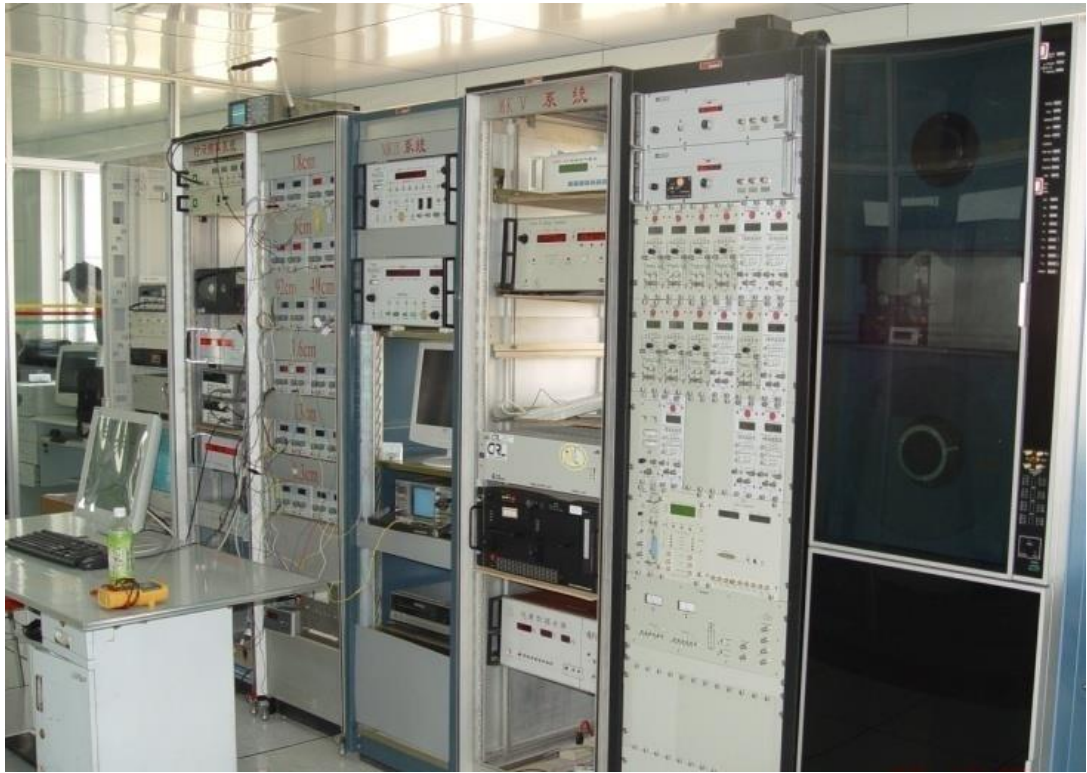
Сурет 2.6 – Сигналды қабылдау және өңдеу станциясы
